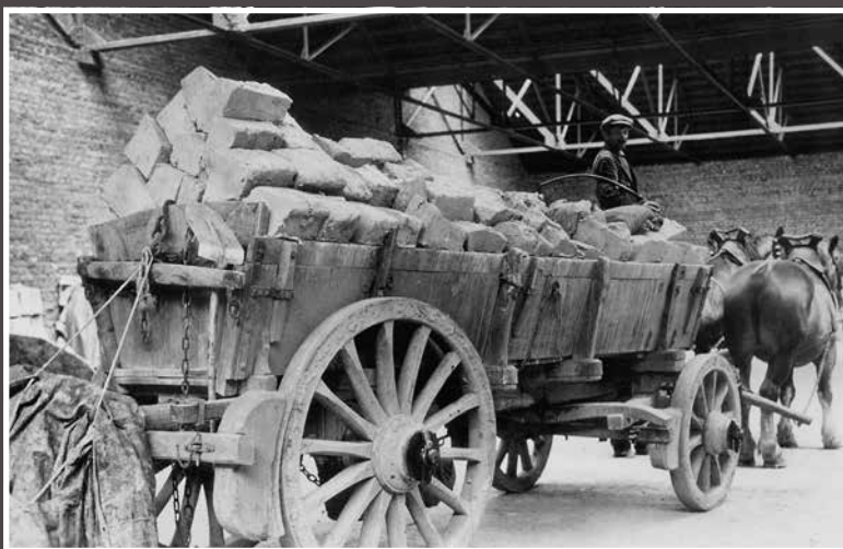
Fig. 195 Chariot chargé de blocs de derle, vers 1950-1960. © Musée de la céramique d'Andenne
